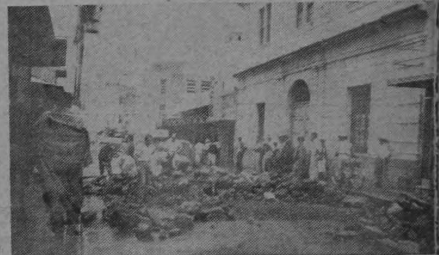
Los autobuses han desviado sus rutas; se arman presas las calles. Todo, por estos trabajos—muy necesarios—se están realizando en la Avenida Tercera (frente a la imprenta Nacional), y que han dado por resultado que la calle esté totalmente abierta (no al tránsito). —
